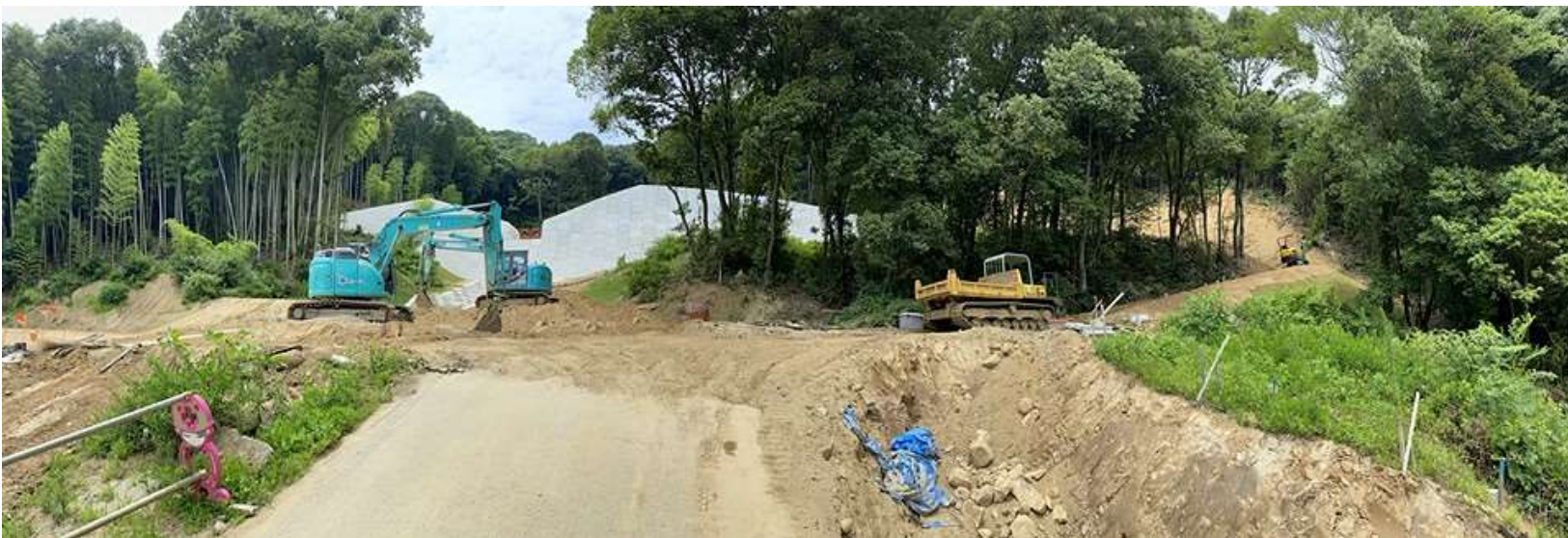
砂防工事状況 (2021.7.4)
